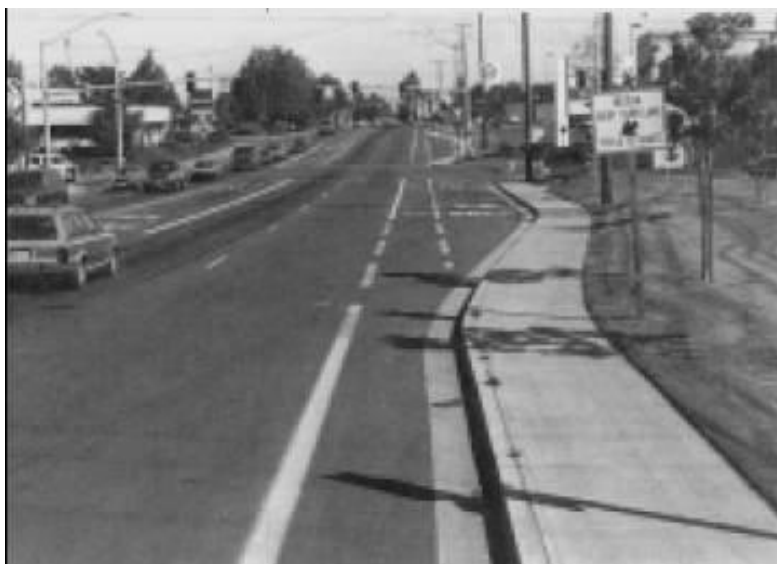
Рисунок 9. Разметка велосипедной дорожки перед перекрестком
