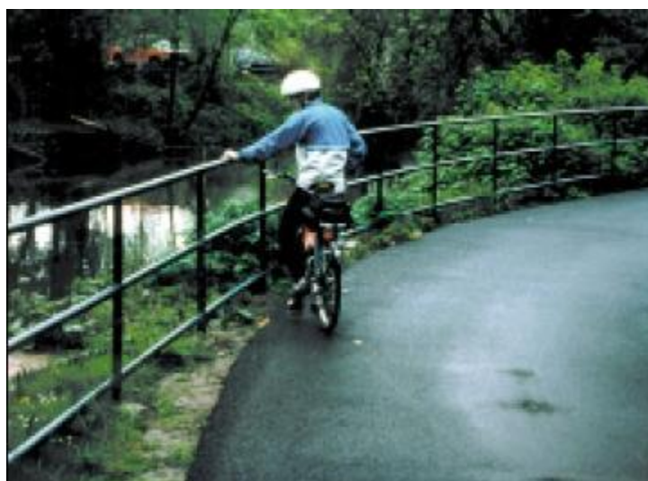
Рисунок 18. Ограждение, отделяющее парковую дорожку совместного использования от склона и реки
