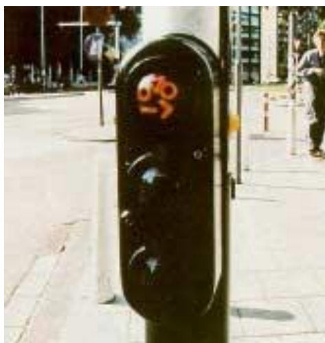
Рисунок 5. Амстердам. Светофор для велосипедистов на пересечении улицы. Кнопка расположена на высоте, удобной для нажатия, не покидая велосипед.
